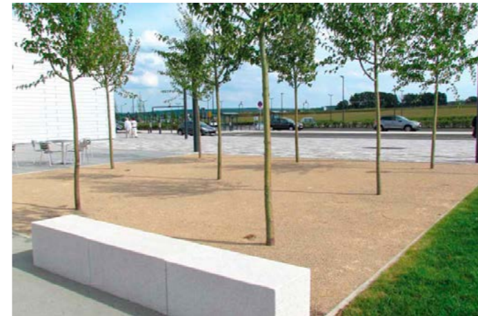
wassergebundene Decke, wasserdurchlässig - geeignet für Aufenthaltsbereiche und Parkplätze - versickerungsfähig - bedingt einsetzbar im Gebäudenahbereich -> Sauberlaufzone erforderlich
