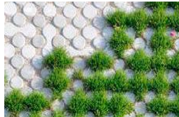
Rasenpflaster, befahrbar und durchlässig - geeignet für Parkplätze und Feuerwehrumfahrten - für Bereiche, wo eine Sichtbarkeit der Befahrbarkeit nicht gewünscht ist - Graphische Gestaltung denkbar.
