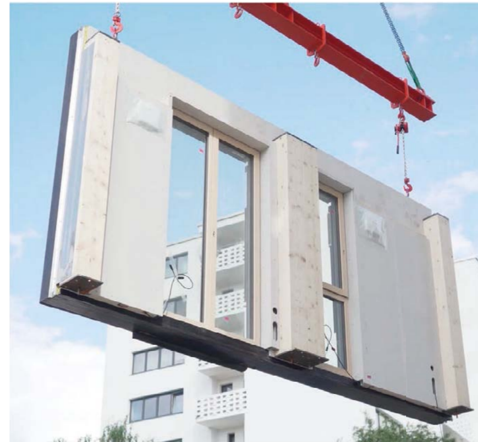
Referenzbild (C) Gropius Holzständerwand als vorgefertigtes Element (hier auch mit Stützen schon angebracht)
