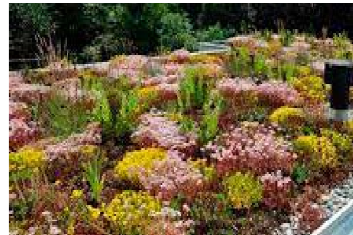
Grün, extensiv BEGEHBAR Extensiv begrünt, Bienenweide, Sedummatten, Steinrosenflur Kombinierbar mit PV-Anlagen Anhögelungen und andere Biodiversitätsbausteine vorzusehen
