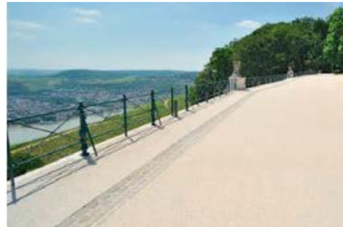
Farbasphalt, wasserundurchlässig - geeignet für Hauptbewegungsflächen zwischen Bestand und Neubau, sowie LOOP - saubere Zuwegung zwischen den Gebäuden - pflegeleicht
