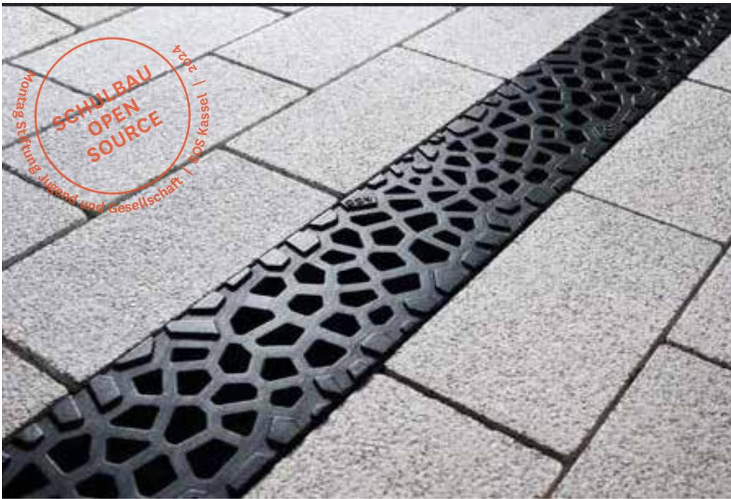
Für die Aussenanlagen im Bereich des Erdgeschosses sind Punkt- und Linienentwässerungen mit Rosten aus Gusseisen vorgesehen.
