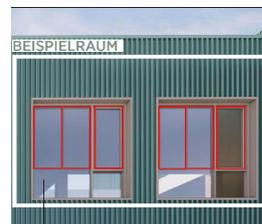
Fenstermodul: aktuelle Gesamtbreite und -höhe 2,6x3,1 m -> ca. 8 m<sup>2</sup>
